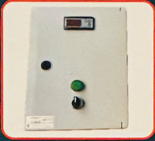
ISI KONTROL PANELİ
